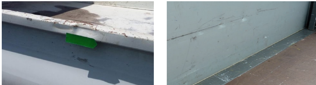
Nieznaczne zadrapania, odkształcenia szyn, czas naprawy \leq 1 h
