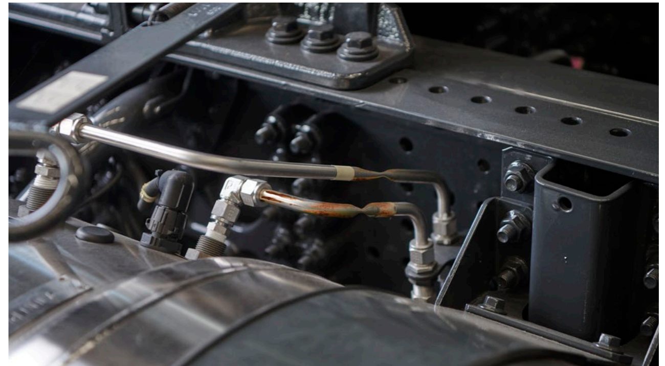
Rdza, wgniecenia, pęknięcia i/lub ubytki → opłata za wymianę sztywnych przewodów.
