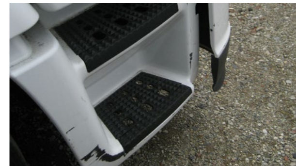
☰ Materialabtrag, defektes Teil
