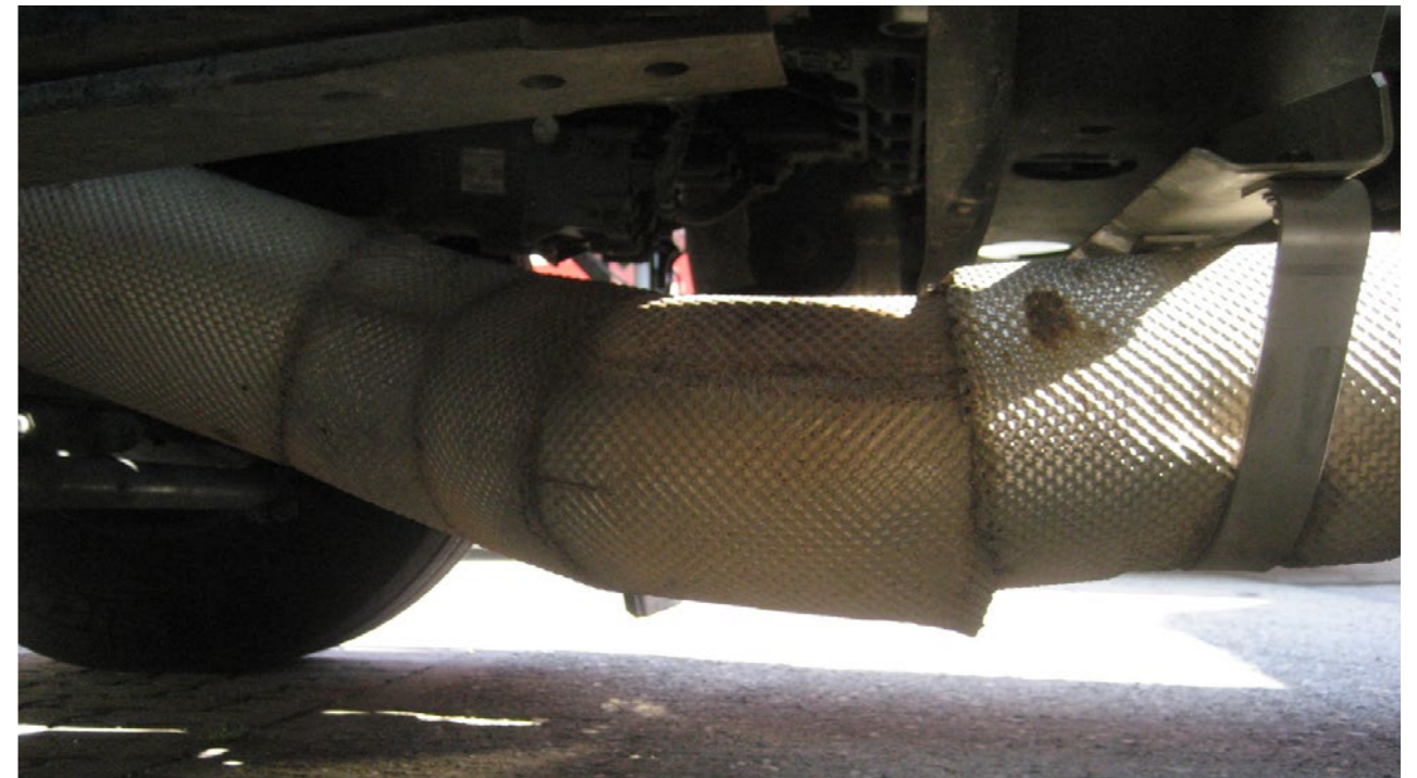
Folgendes wird nicht akzeptiert: gebrochene Rohre, gerissene Wärmedämmung, Kratzer die tief im Material sitzen sowie Dellen, die den Rohrdurchmesser verringern.
